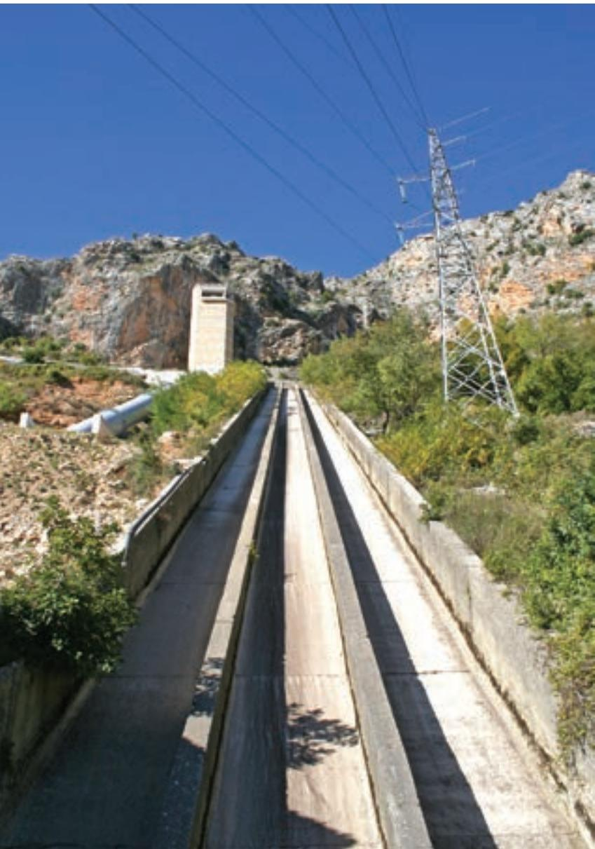
**Zasunska komora** predstavlja jedinstvenu cjelinu s pristupnim tunelom, a u njoj se nalazi pločasti zatvarač dimenzija  $2,1 \times 2,6$  m kojim je moguće zatvoriti dovod vode u cjevovod u svrhu pregleda i održavanja. Taj zatvarač ujedno je i sigurnosni element za rad elektrane. Iza zatvarača je ugrađena odzdračna cijev promjera 80 cm koja sprečava pojavu vakuma u cjevovodu za slučaj njegovog pražnjenja.
