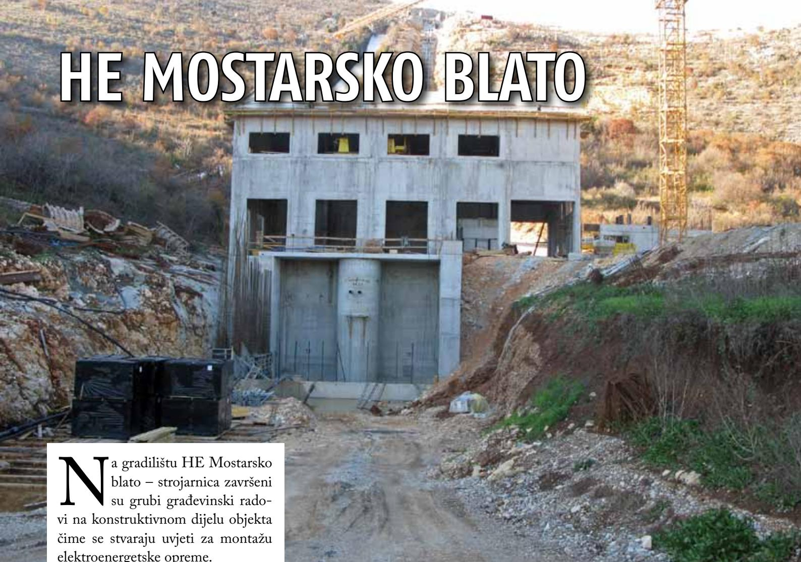
**N**a gradilištu HE Mostarsko blato – strojarnica završeni su grubi građevinski radovi na konstruktivnom dijelu objekta čime se stvaraju uvjeti za montažu elektroenergetske opreme.
