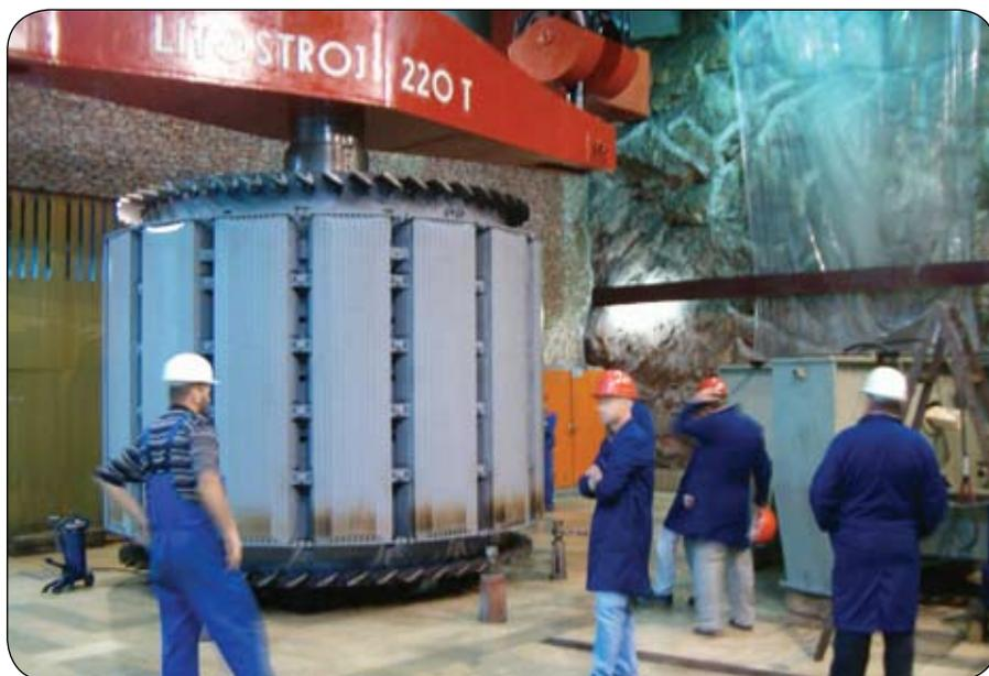
Nakon demontaže, rađeni su: čišćenje i odmaščivanje, defektacija, kontrola i ispitivanje na statoru i rotoru, klizno-kontrolnom sklopu, hladionici, kočnicama, kočničnom prstenu, ležajevima, ležajnom zavrtnju i osovini.
