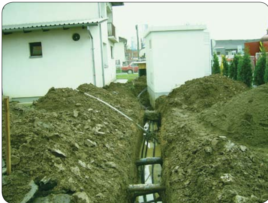
Završni radovi na polaganju SN kabela i montaža KBTS 10(20)/0,4 kV «Bolnica»
