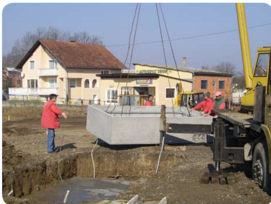
Montaža betonske kade na pripremljeni temelj za KBTS 10(20)/0,4 «Blato 3» u Domaljevcu
