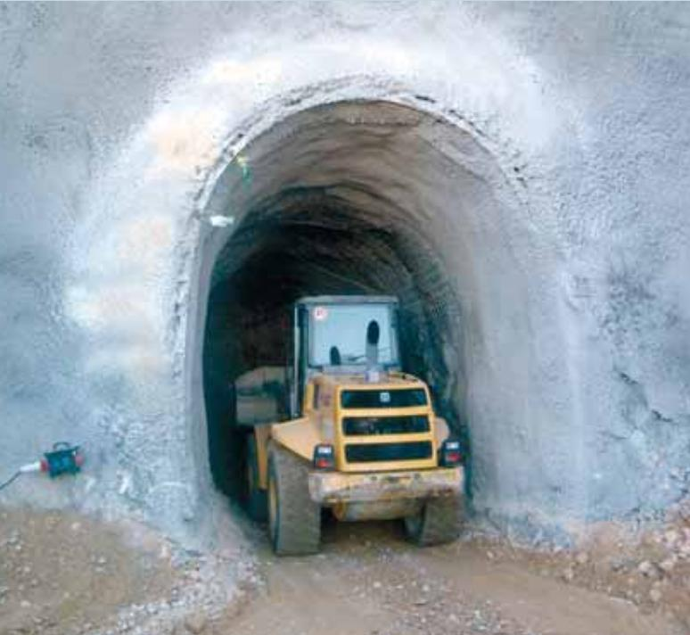
Obloga dovodnog tunela izvodić će se betonom MB-30 debljine 30 cm. Temeljna je ploča armirana na čitavoj dionici dok se betonska obloga izvodi djelomično armirana.
