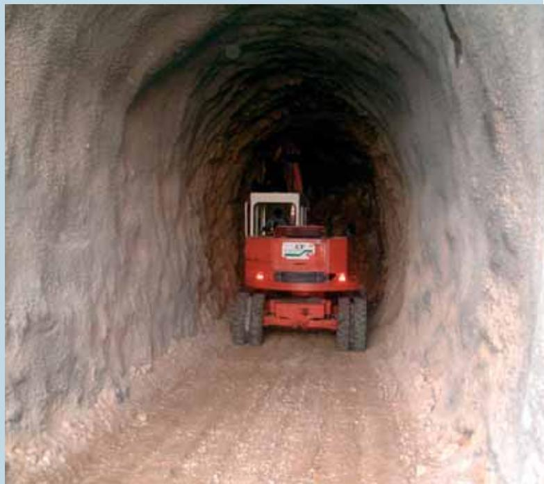
3.12.2006 god. probijeno je i podgrađeno 36 m pristupnog tunela. Dnevno napredovanje u pristupnom tunelu je 6 – 9 m. Radno vrijeme prema uspostavljenoj organizaciji je za iskop i osiguranje iskopa je 24 sata.
